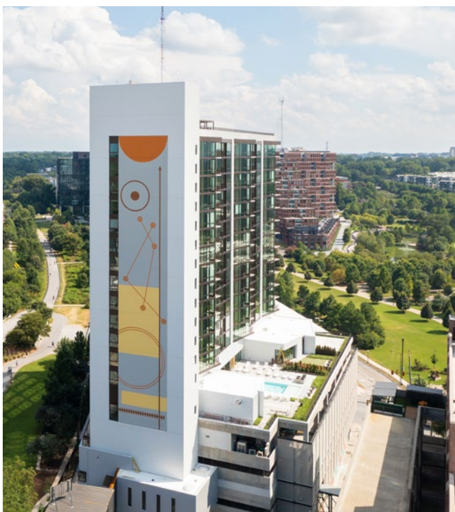
„Signal House“ befindet sich direkt an der bei Spaziergängen und Radfahrern beliebten Beltline.
