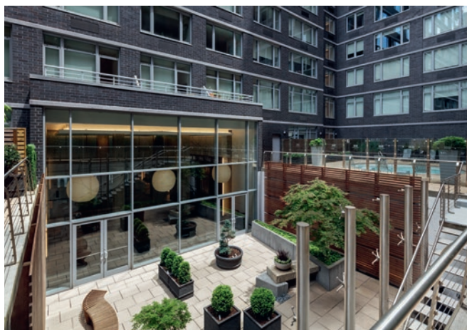
Mietwohngebäude 88 Leonard Street: Die 352 Wohnungen sind zu 98% vermietet
