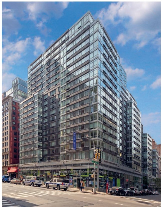
Mietwohngebäude 88 Leonard Street: Die Renovierungsarbeiten der Gemeinschaftsflächen sind abgeschlossen
