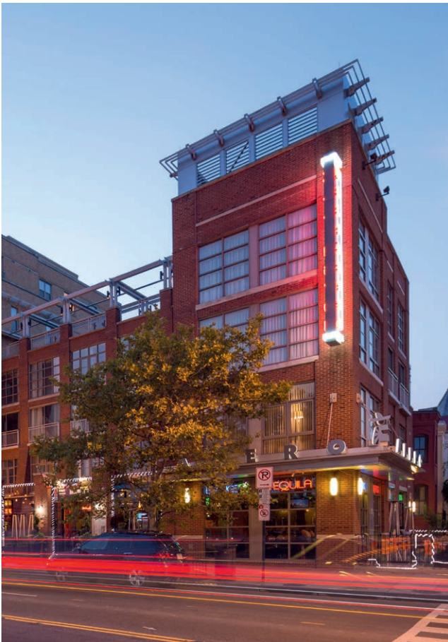
Mietwohngebäude The Ellington in Washington, D.C.
