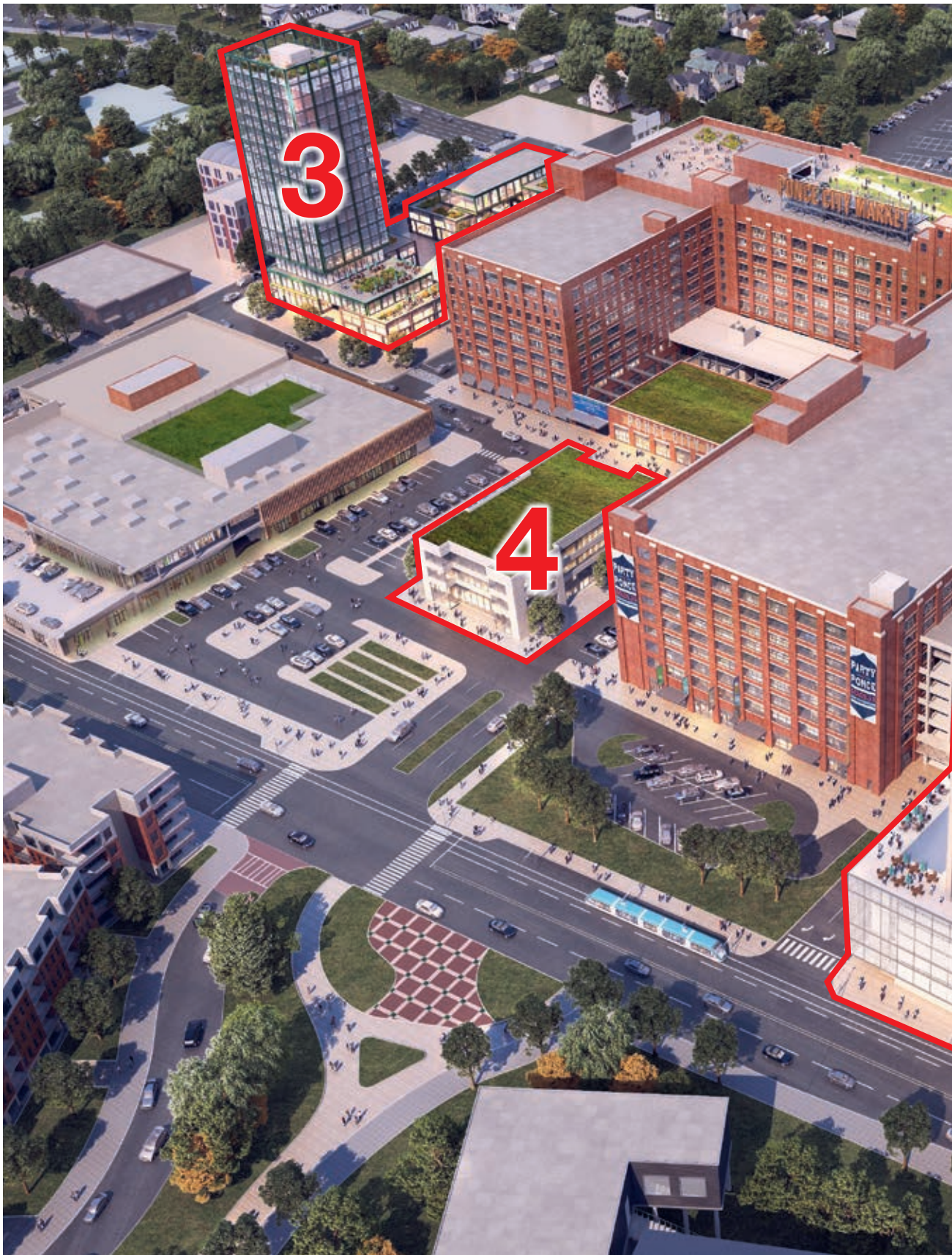
Ponce City Market: Die obige Fotomontage zeigt die von der Stadt Atlanta genehmigten Neubauten (Gebäude 1-4) mit Mietflächen von bis zu 52.000 qm für Büro, Einzelhandel, Hotel und Mietwohnungen. In direkter Nachbarschaft von Ponce City Market entsteht derzeit ein 12-stöckiges Bürogebäude mit einem Supermarkt im Erdgeschoss (Gebäude 5). Rechts von Ponce City Market verläuft die Atlanta BeltLine (6), eine ehemalige Eisenbahnlinie, die auf über 35 km für Fußgänger und Radfahrer ausgebaut wird.
